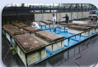
【台船修理の様子】
